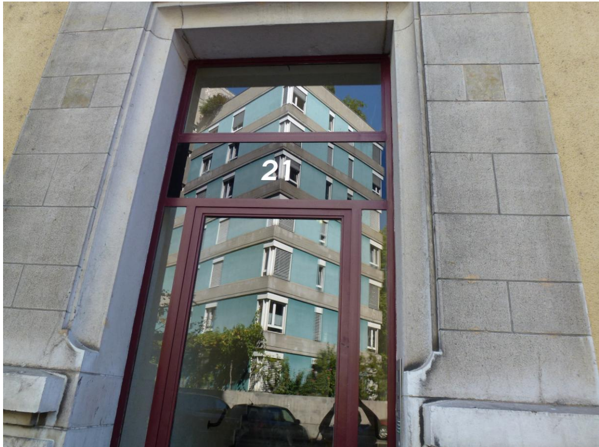
Figure 5: Rue de XX, notre entrée (family B)
