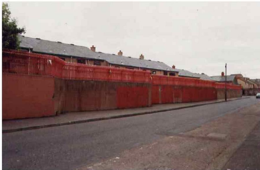
Figure 89 : Bryson Street, mur de sécurité (3 juin 2001)
