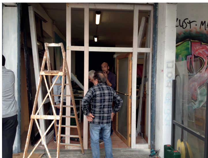
IMMAGINE 2: QUARTIERE CORVIALE (ROMA), LAVORI DI RISTRUTTURAZIONE. FOTOGRAFIA DI EMANUELE R. MESCHINI, 2016.
